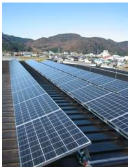
図 2-11 姫川コミュニティスポーツセンターに設置された太陽光発電設備
